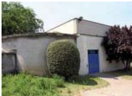
L'acquedotto di San Felice del Benaco
