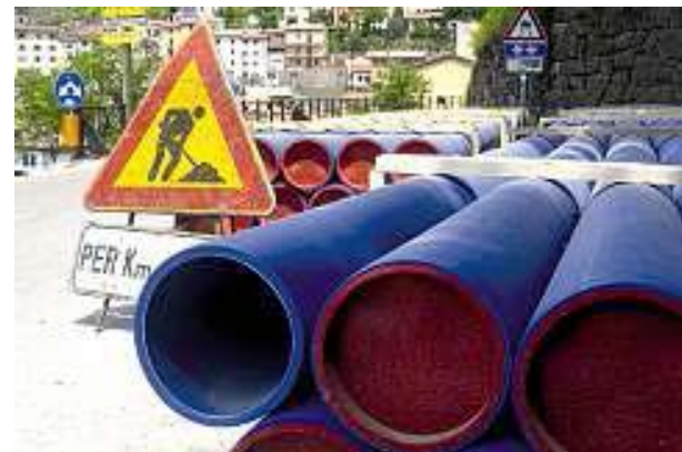
Lavori su un acquedotto: controlli sempre più severi sugli impianti
